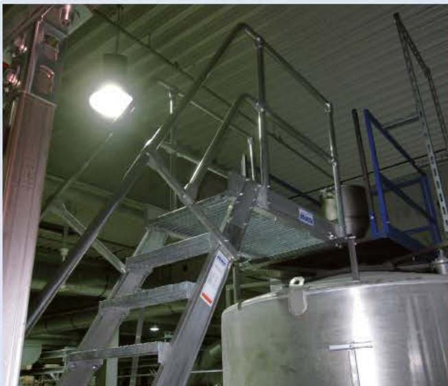
Plattformtreppe mit Gitterroststufen
