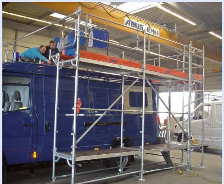
Arbeitsgerüst stationär, U-förmige Arbeitsplattform
