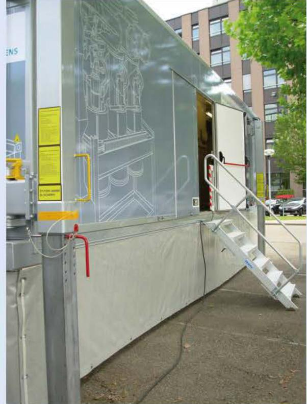
Zugangstreppe, einhängbar mit Gitterroststufen
