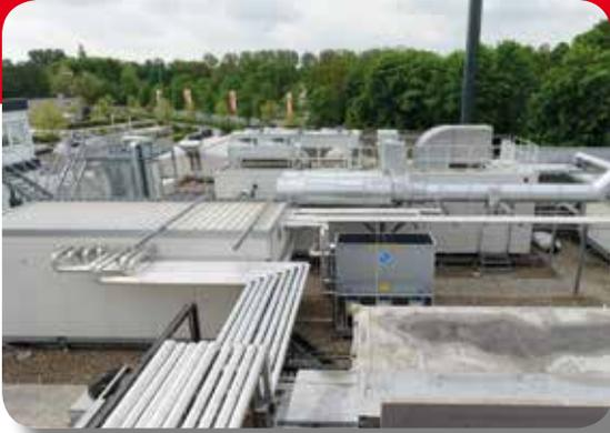
„Das Blockheizkraftwerk ist Teil des Energiekonzepts von Mestemacher. Es ist verbunden mit einer Absorptionskältemaschine und einem Dampferzeuger mit nachgeschaltetem Dampfspeicher.“ Quelle: siehe rechts.
